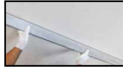
Contrôle de la planéité
