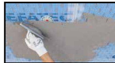
Remplissage et lissage de la natte, spatule crantée dans le sens vertical
