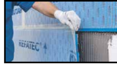
Application des nattes CeraVent du haut vers le bas, en décalé
