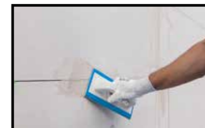
Remplissage des joints
