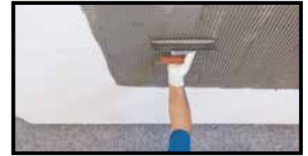
Application de la colle à l'aide d'une spatule crantée dans le sens vertical
