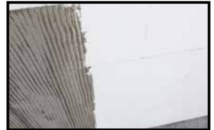
Application première couche PLANITOP HDM MAXI
