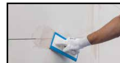
Remplissage des joints
