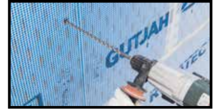
Renforcement: un minimum de 5 chevilles/m 2
