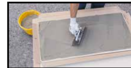
Double application de l'adhésif (dos SLIMTECH)
