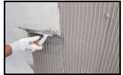
Pose des panneaux isolants avec application d'un double encollage (maçonnerie)
