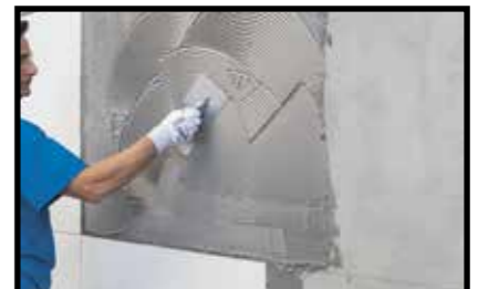
Double application de l'adhésif (maçonnerie)
