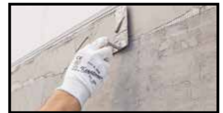
Positionnement du profilé avec incorporation de la natte
