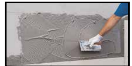
Double application de l'adhésif (maçonnerie)
