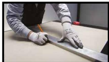
**Fig.2** - Pour couper le plus droit possible, on peut s'aider d'une truelle de maçon en aluminium.
