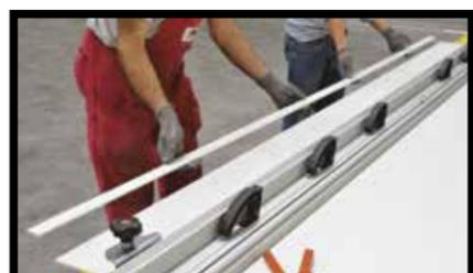
**Fig.5** - Pour faciliter la découpe des carreaux, on peut s'aider d'une carrellette (type Keracut de **Sigma** ou Free-cut de **Raimondi**). En cas d'utilisation de SLIMTECH 3PLUS et SLIMTECH 5PLUS, il faudra, en plus de la carrellette, et après l'incision et la division de la dalle, parfaire l'opération en découpant la fibre de verre à l'aide d'un simple cutter (**Fig.4**).
