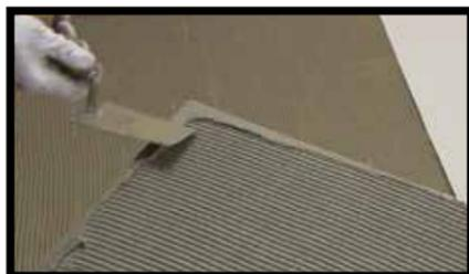
**Fig.29** - Appliquer l'adhésif avec la technique du double encollage qui consiste à étaler le mortier-adhésif sur toute la surface à revêtir (Fig. 61/62), à l'aide d'une spatule crantée (dents de 6 mm de large) (comme, par exemple, Raimondi art.138HFV6). Puis appliquer le mortier-adhésif également sur le dos de la dalle à l'aide d'une spatule crantée (dents de 3 mm de large) Veiller à bien repasser le mortier-adhésif sur le périmètre de la dalle.
