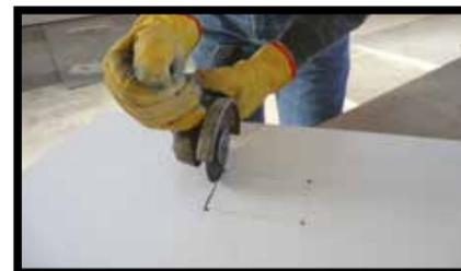
**Fig.11** - Pour la réalisation de découpes internes et de découpes en "L", il est conseillé d'arrondir les sommets de l'ouverture avec des forets de 5 mm minimum afin de diminuer le risque de rupture. Puis, découper au moyen de scies diamantées en ayant soin de ne pas interrompre l'avancement une fois que le trou précédemment réalisé aura été atteint. Pour l'exécution de trous et de découpes au moyen de scies diamantées, suivre les indications fournies précédemment.
