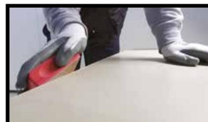
**Fig.12** - Les finitions des bords peuvent être exécutées manuellement au moyen d'éponges diamantées ou de papier émeri. Passer légèrement sur le côté de la dalle pour l'arrondir partiellement ou bien effectuer plusieurs passages pour obtenir un effet biseauté.
