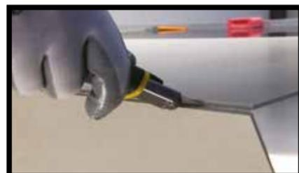
**Fig.4** - Pour les articles SLIMTECH 3PLUS et SLIMTECH 5PLUS, il faudra parfaire l'opération en découpant la fibre de verre à l'aide d'un simple cutter, après l'incision de la partie céramique et la division de la dalle.
